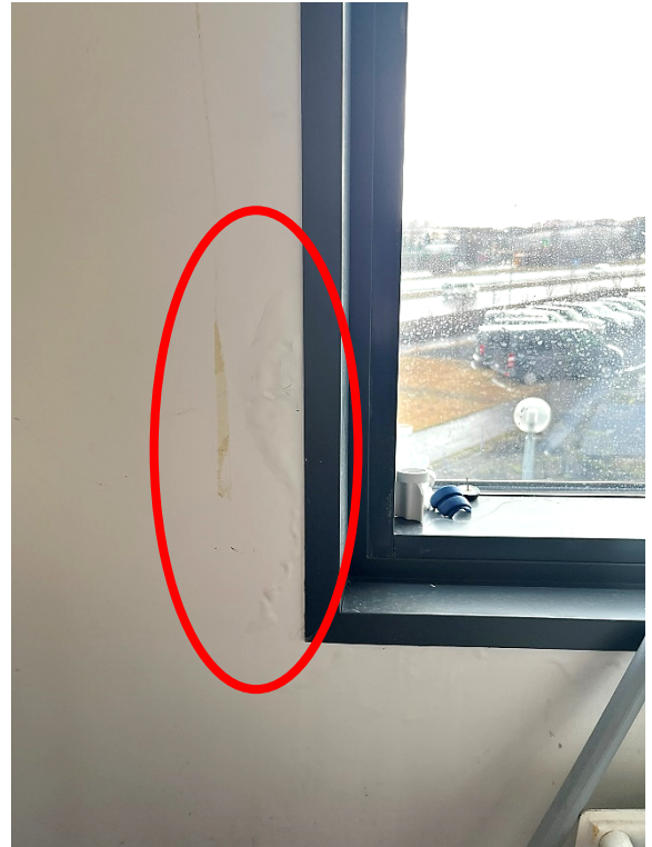
Mynd 2. Ummerki um raka á vegg í ræstirými.
